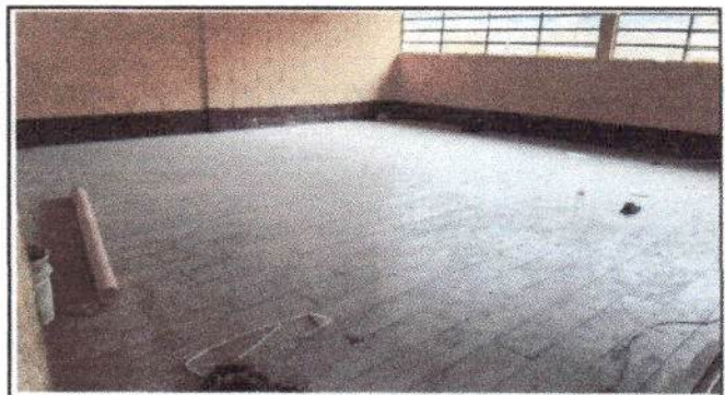
Foto 4: Esta es la instalación del piso ceramico de las aulas.
